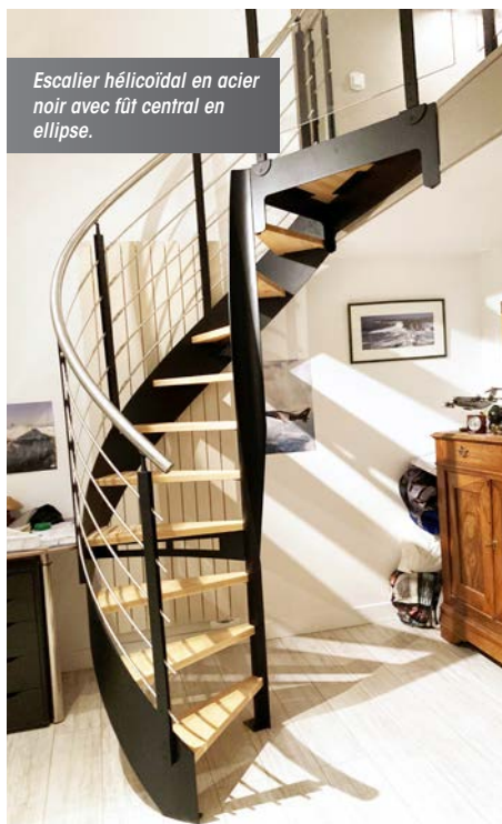
Escalier hélicoïdal en acier noir avec fût central rond.
